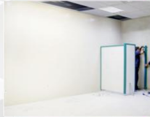
۱۰ نصب قطعه دیواری
