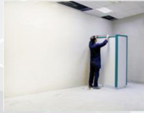
۶ تنظیم و تراز کردن اولین پانل
