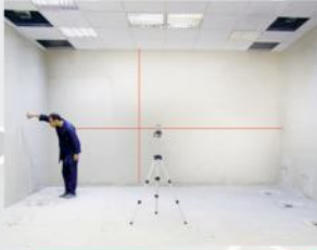
۱ تعیین ارتفاع سطح کف در نقاط مختلف
