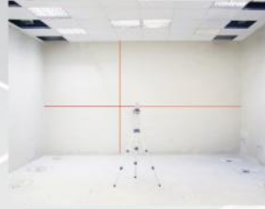
۳ تعیین اختلاف سطح کف با دستگاه لیزر
