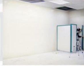
۱۱ تنظیم قطعه دیواری
