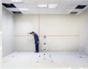
۲ تعیین اختلاف سطح کف با تراز لیزری
