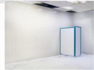
۱۲ تثبیت اولین پانل به زمین و دیوار
