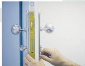
۱۸ نصب براق آلات
