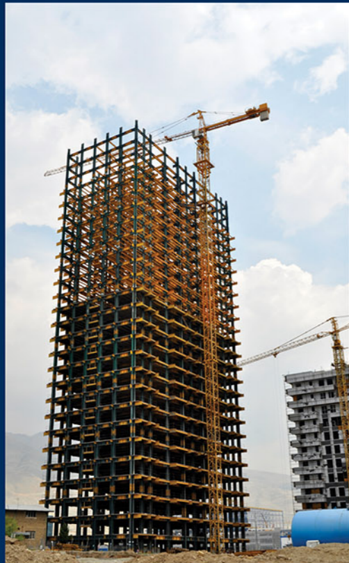
اسکلت فلزی برج ۳۹ طبقه تعاونی مسکن مرکزی نهجا
