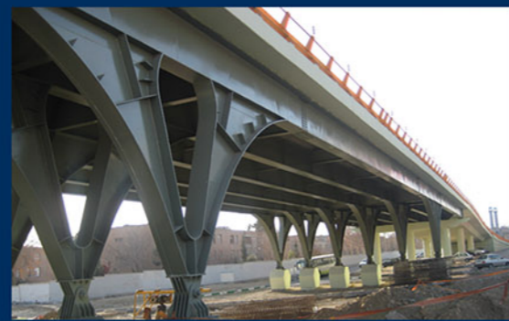
پل تقاطع باکری - کاشانی - تهرانی
