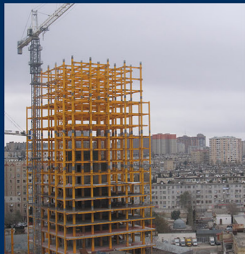
برج های اداری تجاری مسکونی نسیم باکو
